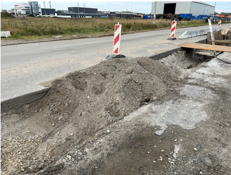
Figur 6 – viser ledningsgrav anlagt med begrænset arbejdsareal
