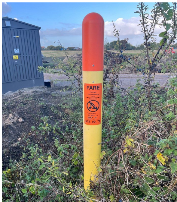
Figur 13 - Billede af mærkestander, der markerer gasledning
