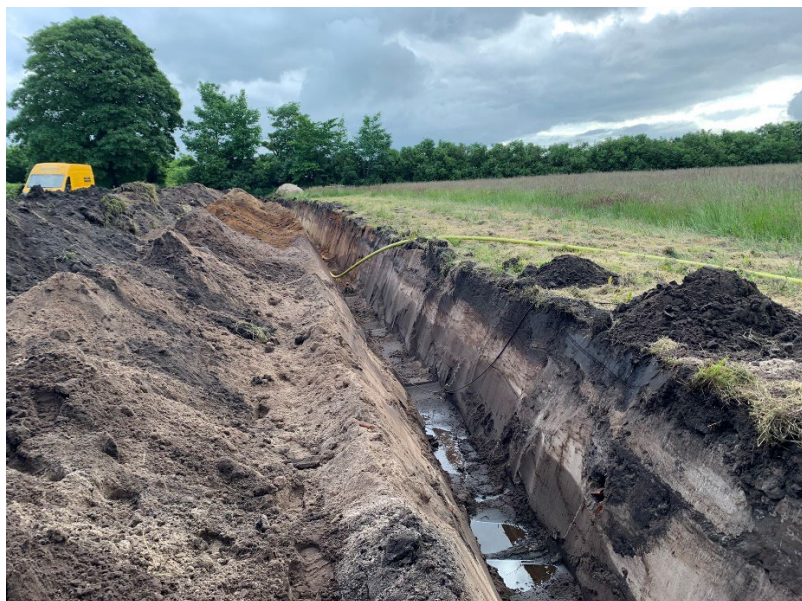
Figur 3 – Eksempel på anlæggelse af gasledning i åben ledningsgrav.
