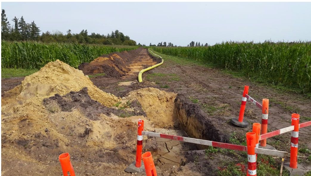
Figur 8 – Eksempel på boregrube (forgrunden) og arbejdsbælte for ledningsanlægget (baggrunden)
